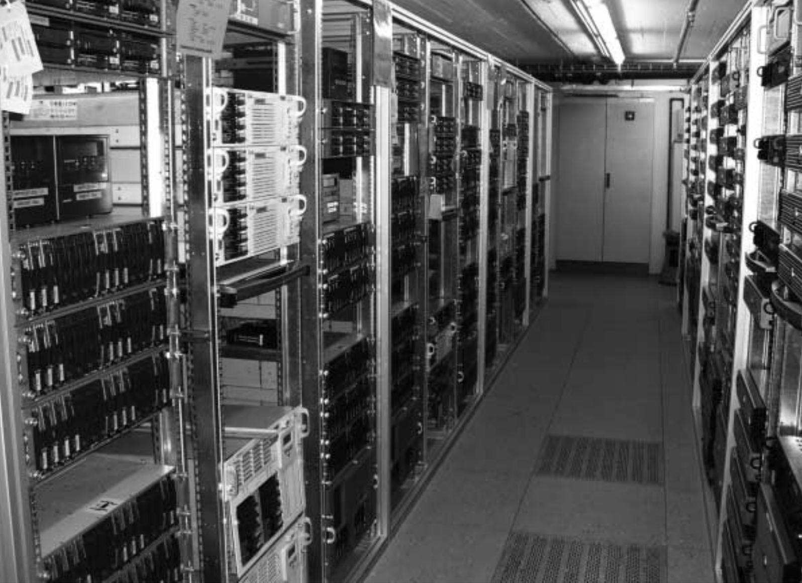
Ein Beispiel für die Ausrichtung der euromicron auf anspruchsvolle Systemtechnik ist der Ausbau des Rechenzentrums der „Verlagsgruppe Handelsblatt Düsseldorf“. Die komplette Rechenzentrumslösung mit Datenetz, Notstromversorgung, USV-Anlage und Klimatechnik erfolgte durch die delcom GmbH in Essen. Es wurden ca. 45 km Kupfer-, ca. 5 km Glasfaser- und ca. 2000 Stück Patchkabel verlegt.
