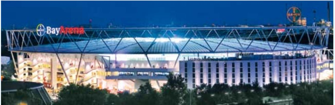
Beeindruckend auch bei Nacht: Das Makrolon®-Dach der neuen BayArena hat einen Durchmesser von 217 Metern.
